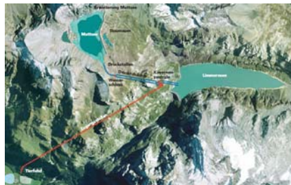
Bild: Übersicht über die Erweiterungsbauten beim Projekt Linthal 2015.
